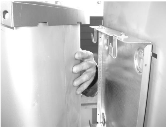
Abbildung 9: Montage des Öltanks
