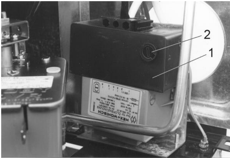
Abbildung 16: Zündtransformator 1 Zündtransformator 2 Schraubkappe mit Feinsicherung
